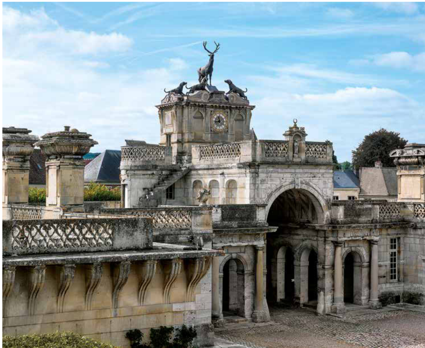
Ouvrage d'entrée, château d'Anet (Eure-et-Loir).
