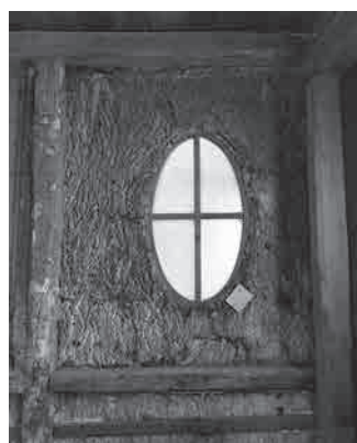
Figure 6: Détail du revêtement intérieur
