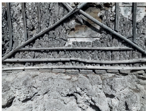
Figure 4: Le socle en pierre surmonté d'une rangée de briques
