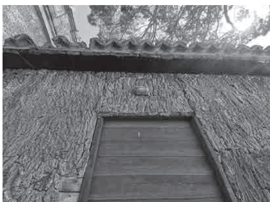
Figure 5: Restes de liège sur l'encadrement d'une porte
