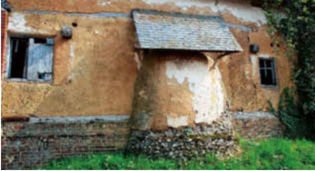
LE CUL-DE-FOUR RECOUVERT DE TORCHIS FORME UNE EXCROISSANCE DANS LE MUR DE LA MAISON PICARDE.
