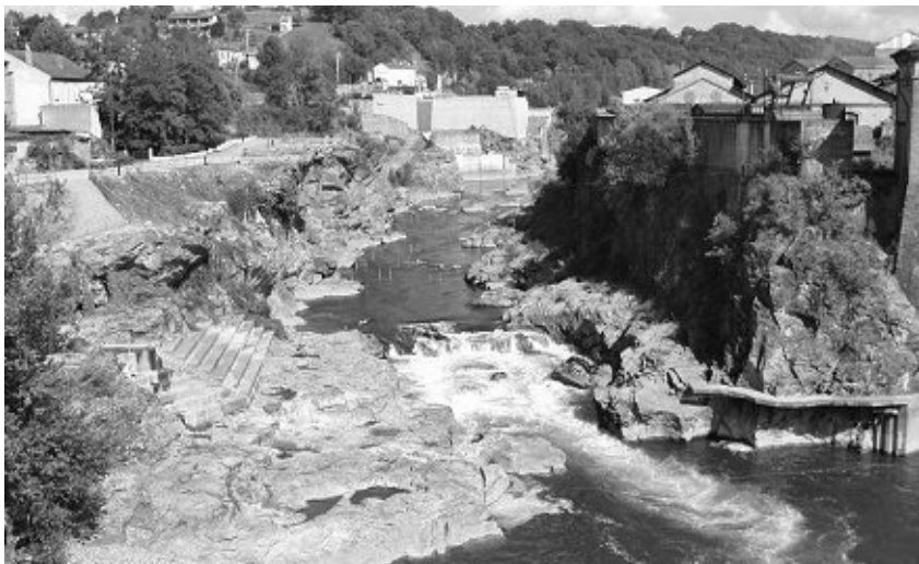
L'usine hydroélectrique du Saut-de-Sabo sur le bas Tarn
